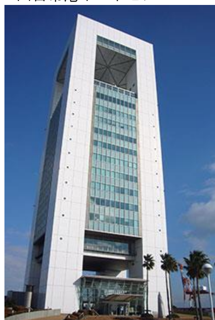
平成 11 年（1999 年）竣工
