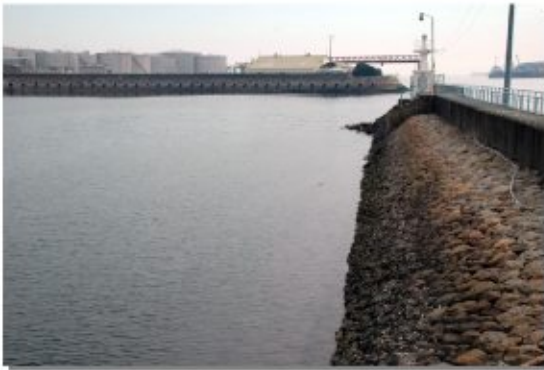
旧港西防波堤（右）と潮吹き防波堤（奥）
