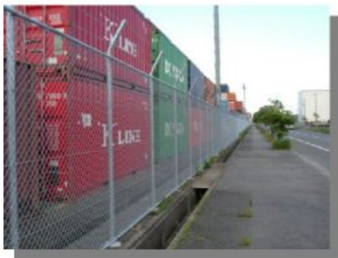
～SOLAS条約によるフェンス～
