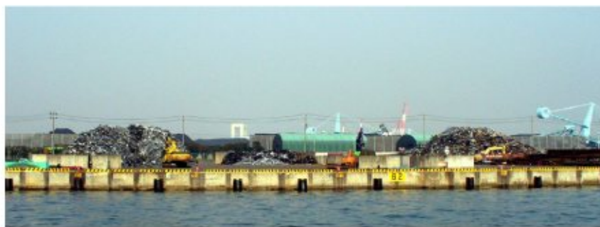
循環資源（金属くず）の取扱
