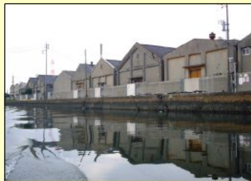
図4.7 千歳運河沿いの倉庫群
