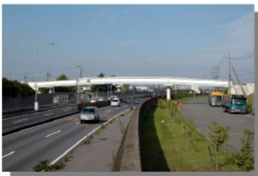
～富田地区と富双緑地を結ぶ歩道橋～
