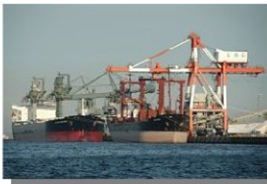
～霞ヶ浦南埠頭2・23号岸壁で荷役中のバルク船～
