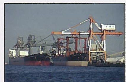
～霞ヶ浦南埠頭 22・23号岸壁で荷役中のバルク船～
