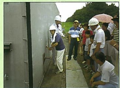
～防潮扉の閉鎖に関する説明風景～
