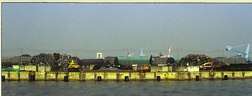
～循環資源(金属くず)の取扱～
