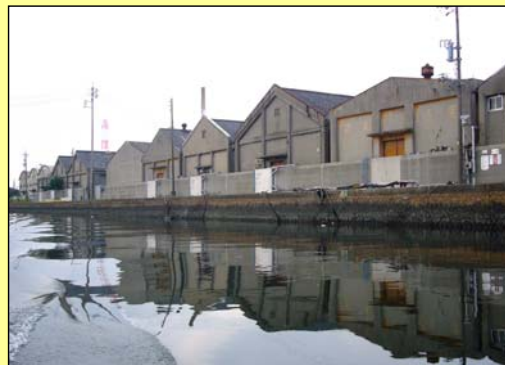
図 2.28 千歳運河沿いの倉庫群
