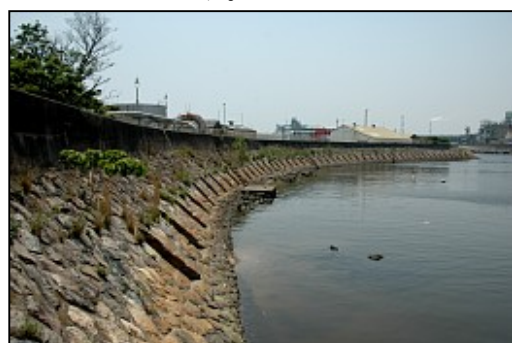
図 2.15 潮吹き防波堤 (重要文化財)
