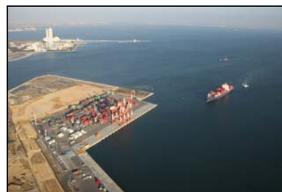
図 2.21 コンテナターミナル建設予定海域
