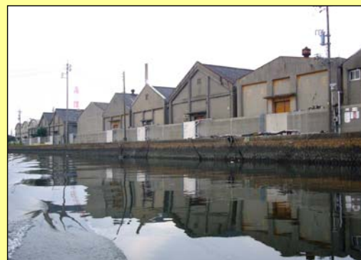
図 2.28 千歳運河沿いの倉庫群
