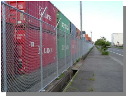
～SOLAS条約によるフェンス～
