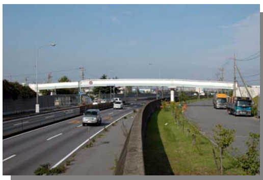
～富田地区と富双緑地を結ぶ歩道橋～
