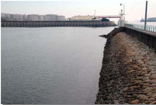
旧港西防波堤（右）と潮吹き防波堤（奥）
