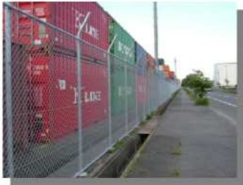
～SOLAS条約によるフェンス～
