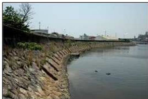
図 2.15 潮吹き防波堤 (重要文化財)
