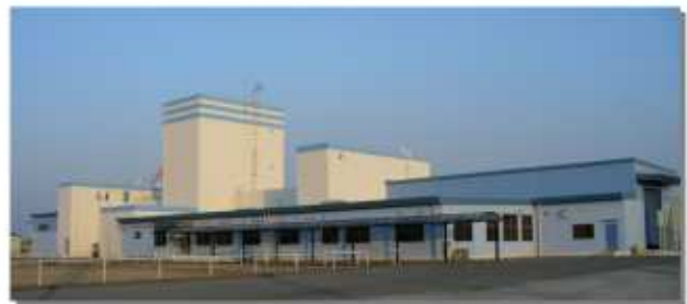
四日市コンテナ検査センター
