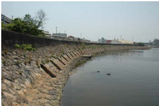
潮吹き防波堤
