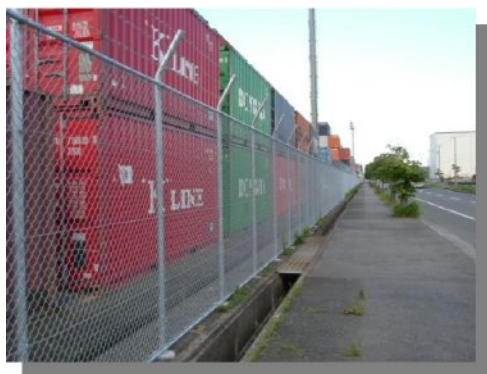
～SOLAS条約によるフェンス～
