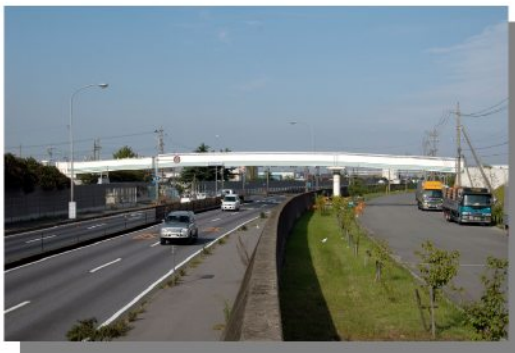
～富田地区と富双緑地を結ぶ歩道橋～
