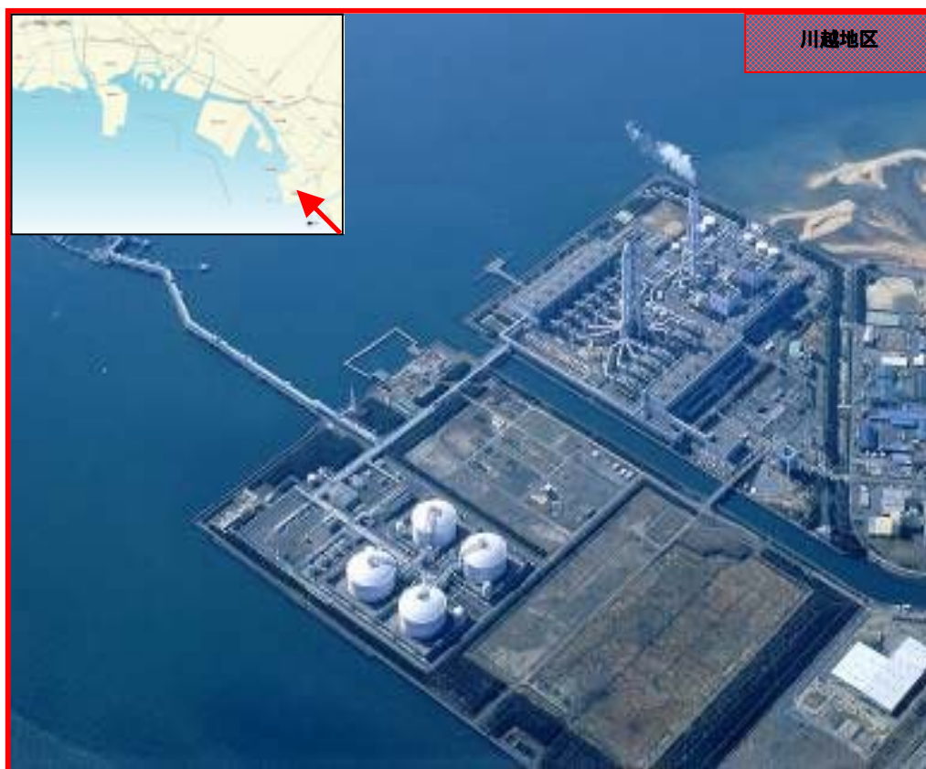
図 3.3.4 川越地区の現状
