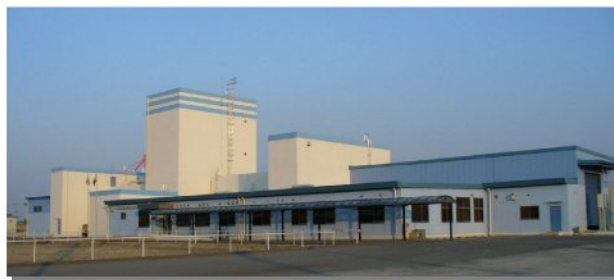
四日市コンテナ検査センター
