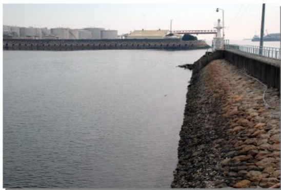
旧港西防波堤（右）と潮吹き防波堤（奥）
