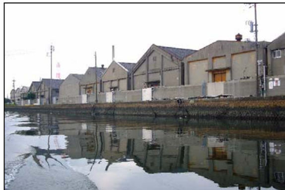
千歳運河沿いの倉庫群
