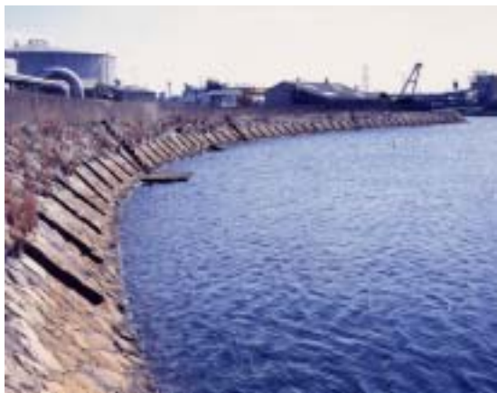
重要文化財に指定された「潮吹き防波堤」
