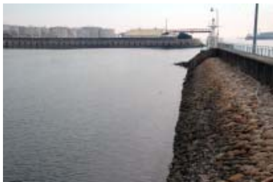
旧港西防波堤（右）と潮吹き防波堤（奥）
