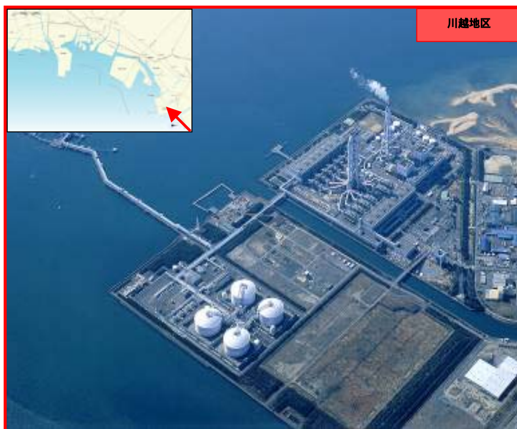
図 3.3.4 川越地区の現状
