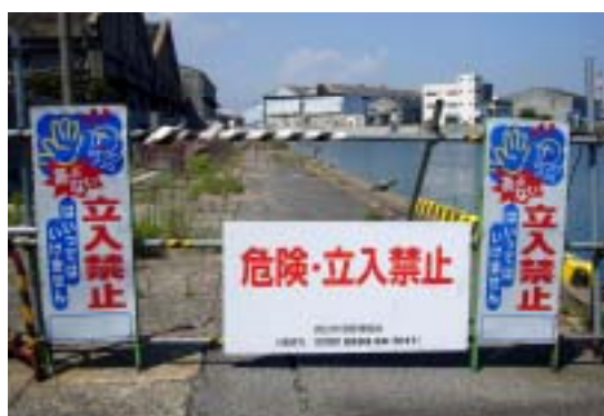
事故防止のため立入制限した物揚場
