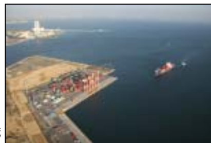
図 3.19 コンテナターミナル建設予定海域
