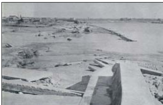
図4.2.8 伊勢湾台風の被害状況
