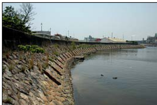
図 3.14 潮吹き防波堤 (重要文化財)
