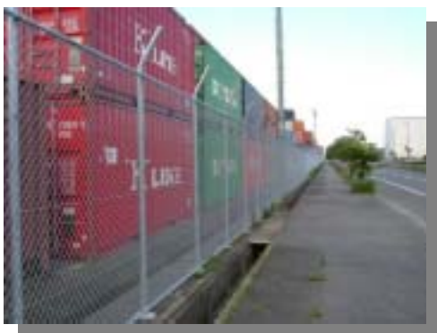
～ SOLAS条約によるフェンス～
