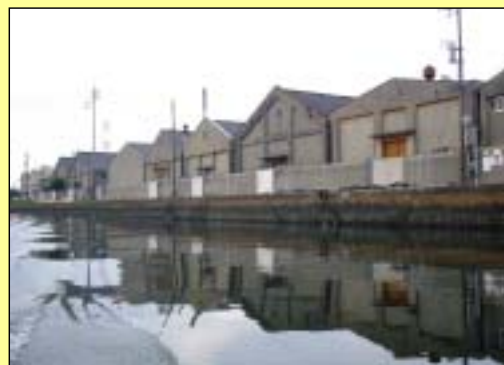
図4.7 千歳運河沿いの倉庫群
