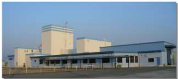
四日市コンテナ検査センター
