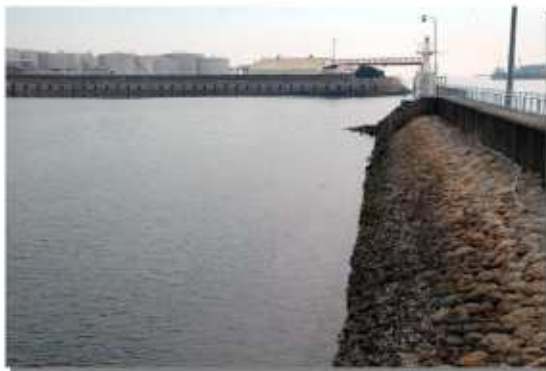
旧港西防波堤（右）と潮吹き防波堤（奥）
