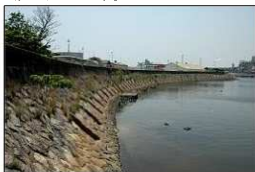
図 2.15 潮吹き防波堤 (重要文化財)
