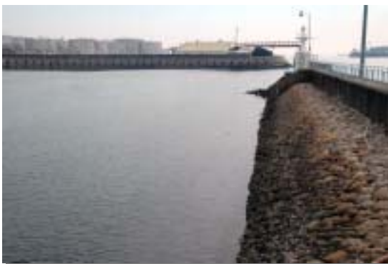
旧港西防波堤（右）と潮吹き防波堤（奥）
