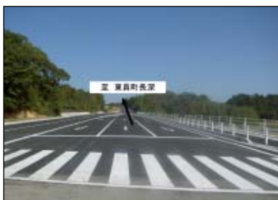
図 3.6.4 一般国道 365 号員弁バイパス H19.11 供用開始部
