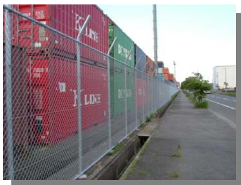
～SOLAS条約によるフェンス～
