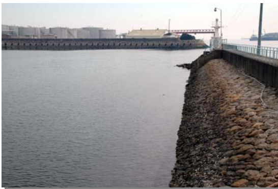
旧港西防波堤（右）と潮吹き防波堤（奥）
