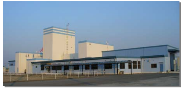
四日市コンテナ検査センター
