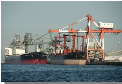
～霞ヶ浦南埠頭22・23号岸壁で荷役中のバルク船～
