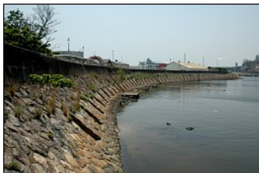
図 2.15 潮吹き防波堤 (重要文化財)
