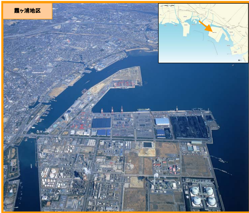
図 4.3.5 霞ヶ浦地区の現状
