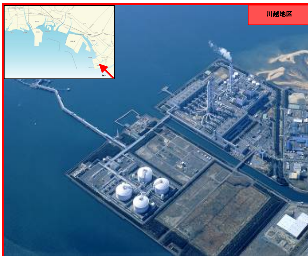
図 4.3.4 川越地区の現状
