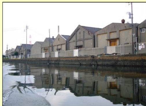
図4.7 千歳運河沿いの倉庫群
