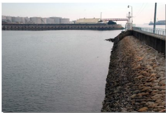
旧港西防波堤（右）と潮吹き防波堤（奥）
