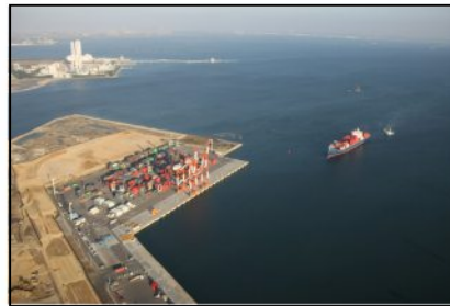
図 3.19 コンテナターミナル建設予定海域
