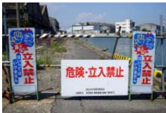
事故防止のため立入制限した物揚場
