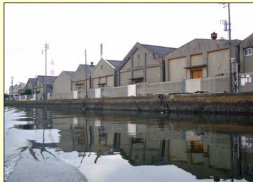
図 2.28 千歳運河沿いの倉庫群
