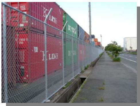
～SOLAS条約によるフェンス～
