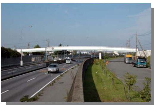
～富田地区と富双緑地を結ぶ歩道橋～
