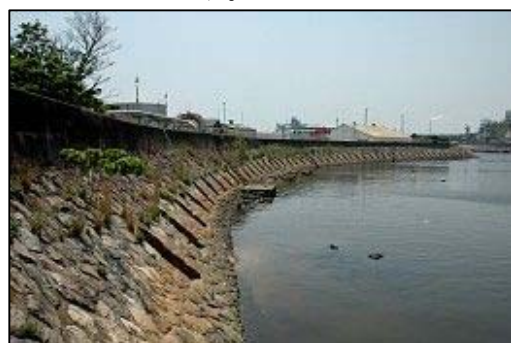
図 2.15 潮吹き防波堤 (重要文化財)
