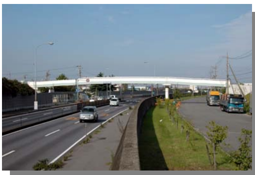
～富田地区と富双緑地を結ぶ歩道橋～
