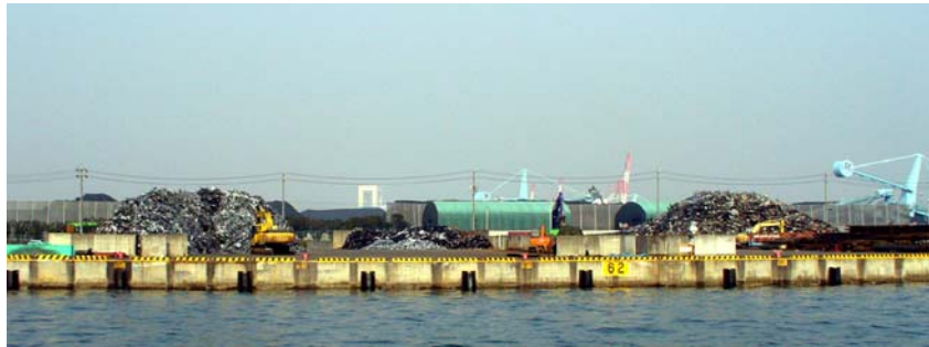
循環資源(金属くず)の取扱
