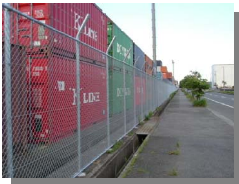
～SOLAS条約によるフェンス～
