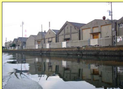
図 2.28 千歳運河沿いの倉庫群
