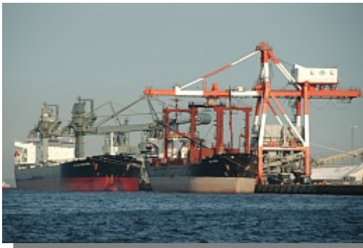
～霞ヶ浦南埠頭2・23号岸壁で荷役中のバルク船～
