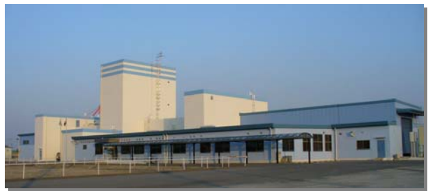
四日市コンテナ検査センター
