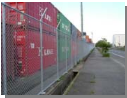
～ SOLAS条約によるフェンス～
