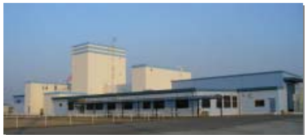
四日市コンテナ検査センター
