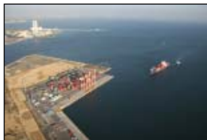
図 3.19 コンテナターミナル建設予定海域
