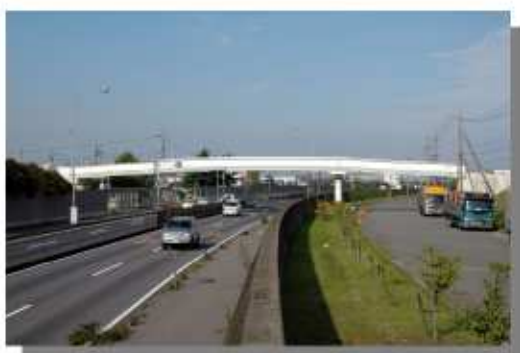
～富田地区と富双緑地を結ぶ歩道橋～
