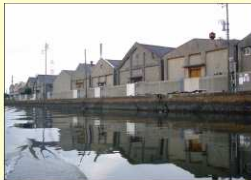
図 2.28 千歳運河沿いの倉庫群
