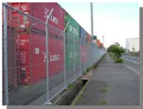
～SOLAS条約によるフェンス～
