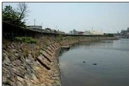
図 2.15 潮吹き防波堤 (重要文化財)
