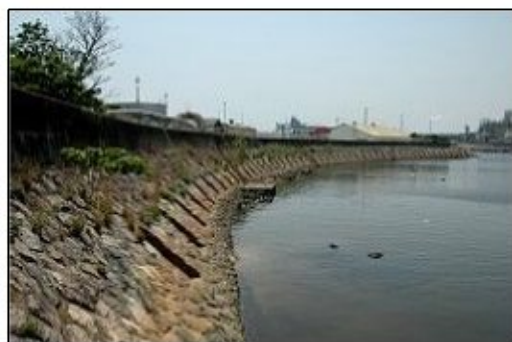
図 3.14 潮吹き防波堤 (重要文化財)
