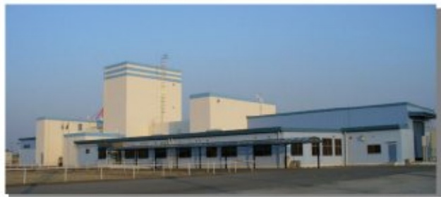
四日市コンテナ検査センター
