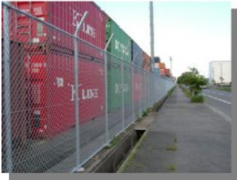
～SOLAS条約によるフェンス～
