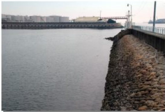
旧港西防波堤（右）と潮吹き防波堤（奥）
