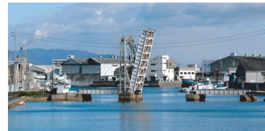
末広橋梁 - 四日市港にある重要文化財 -
