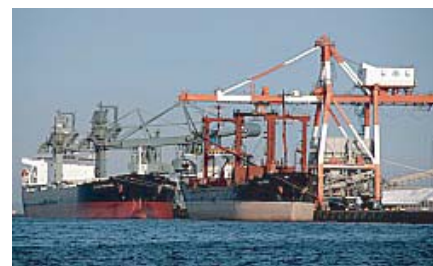
霞ヶ浦南埠頭2.2・2.3号岸壁で荷役中のバルク船
