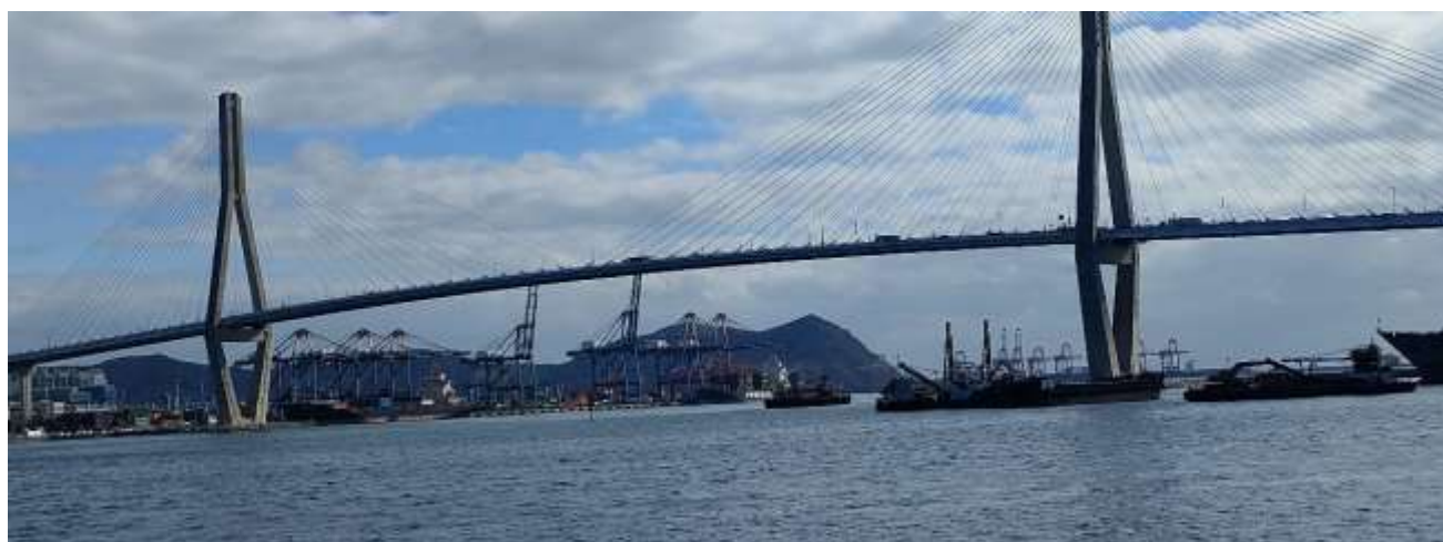
釜山港大橋、そしてシンガンマンコンテナターミナルを望む（北港）船舶より
