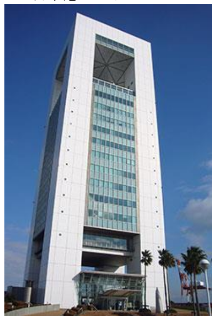
平成 11 年（1999 年）竣工
