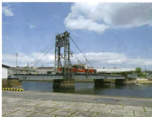
重要文化財に指定されている「末広橋梁」
