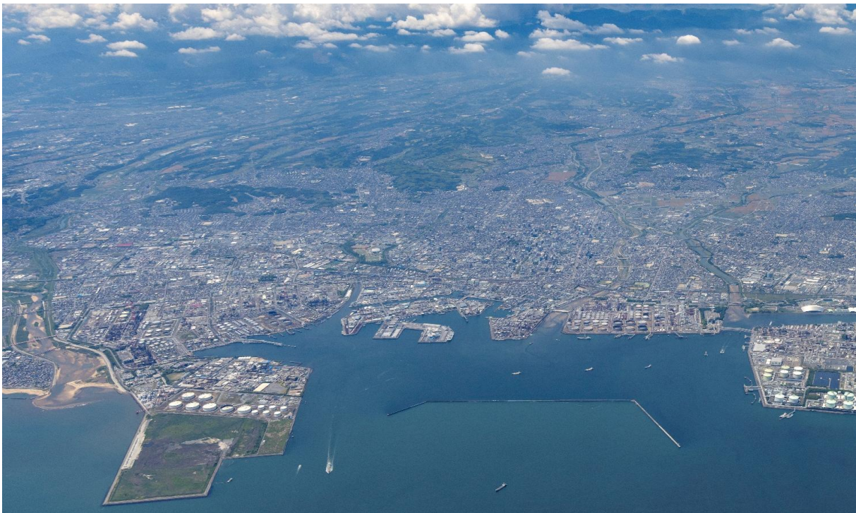
◆四日市地区、塩浜地区、石原地区
