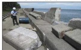
高波による護岸倒壊（神奈川県横浜市）
