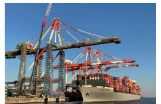
ガントリークレーン修繕の様子
