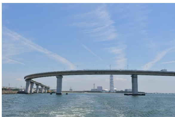
臨港道路「霞 4 号幹線」 (平成 30 年 4 月 1 日供用開始)
