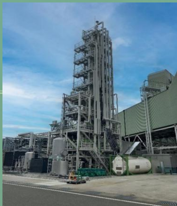
出典：関西電力（株）姫路第二発電所 CO 2 分離・回収技術の実証試験
